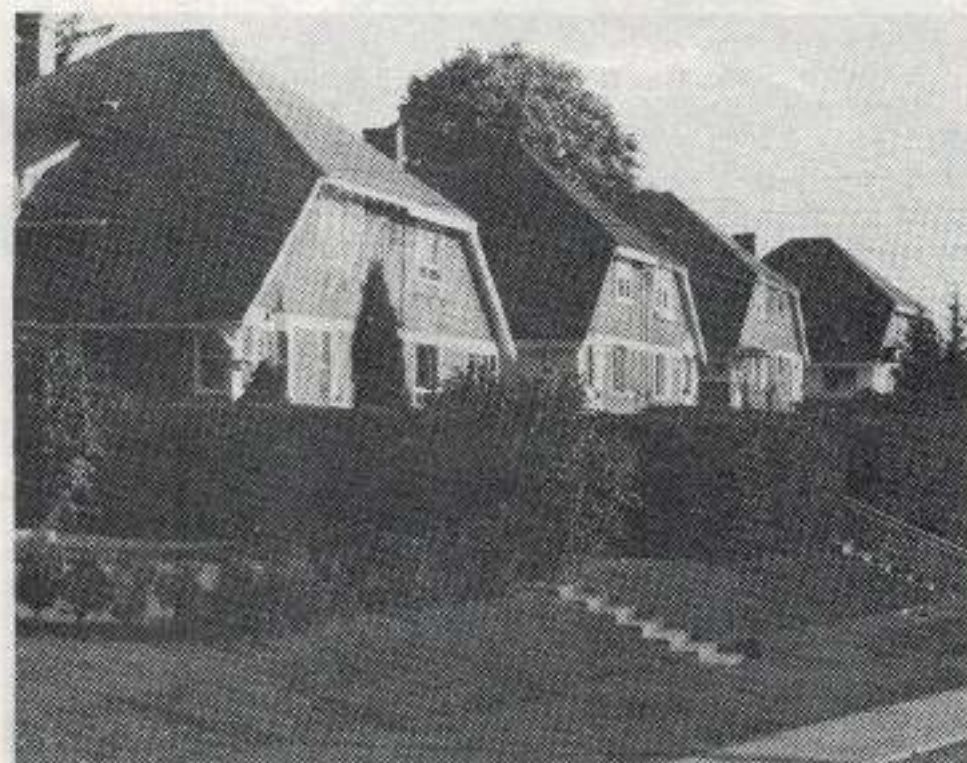
Quelques maisons sur l'avenue Garden City construites à l'intention des travailleurs au début des années 1920.
